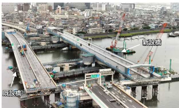
既設橋のスライド撤去状況
