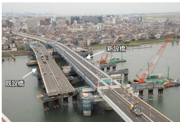
新設橋のスライド架設状況
