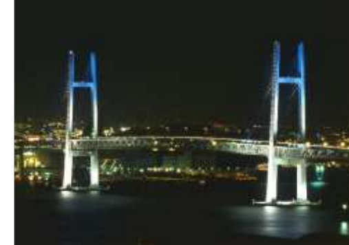
横浜港を渡る斜張橋 (神奈川県横浜市)
