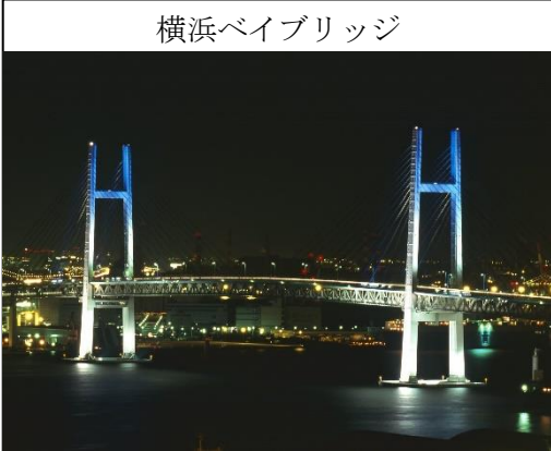
横浜ベイブリッジ 横浜港に架かる斜張橋 (神奈川県横浜市)
