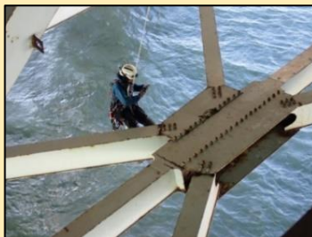
近接点検（ロープによるアクセス）
