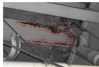
補強鋼板の腐食 目黒線(2015.4.21)
