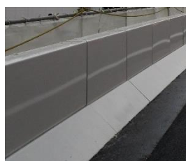
耐久性の高い塗装をした鋼製高欄へ取替
