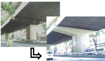
コンクリート橋脚はく落防止対策
