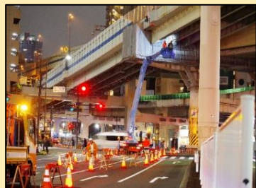
接近点検（往路上）
