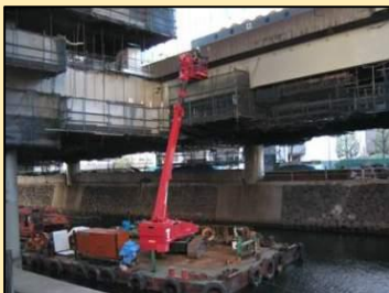
近接点検（河川上）
