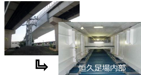
仮設足場の設置困難箇所へ設置
