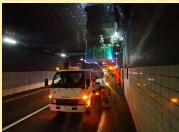
近接点検（トンネル内）
