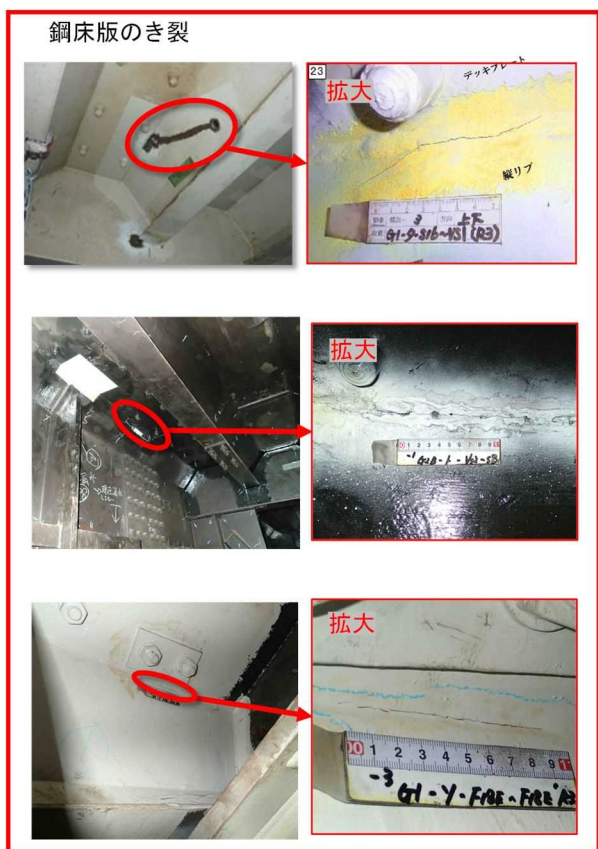
高速大師橋 損傷状況
