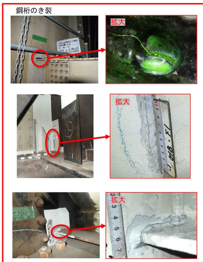
高速大師橋 損傷状況
