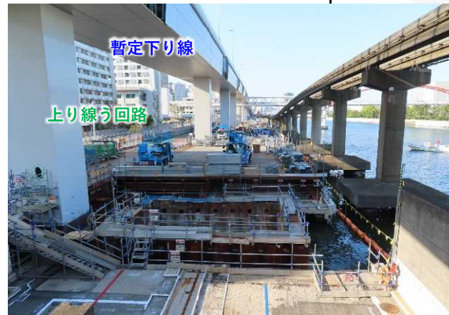
写真② 東品川栈橋部 橋脚基礎工
