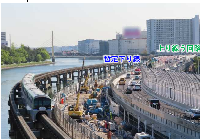
写真① 鮫洲埋立部 地盤改良工
