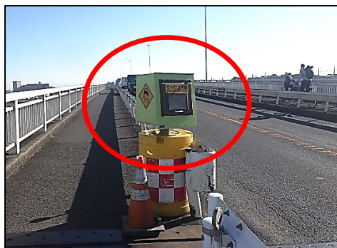
国道1号馬入橋(神奈川県平塚市)
