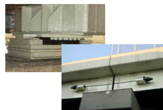
支承取換えと落橋防止構造等による耐震補強
