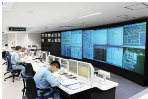
施設管制室での監視
