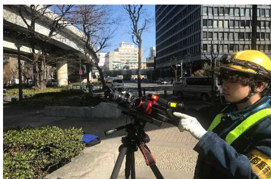
高精細カメラによる構造物点検
