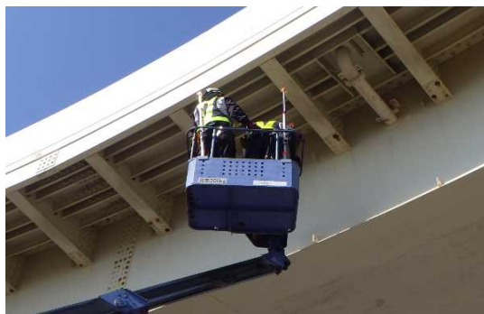
高所作業車による構造物接近点検
