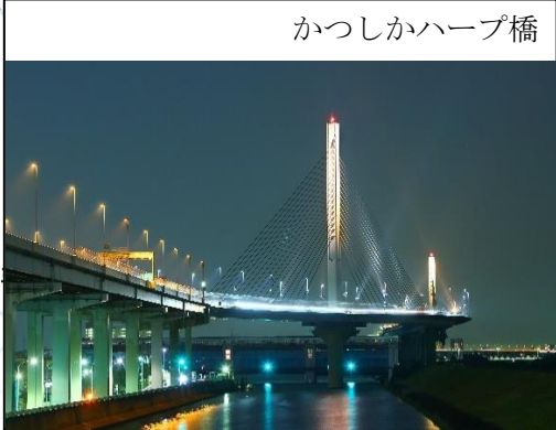
東京都葛飾区 (1987年開通) 綾瀬川にかかるS字形曲線斜張橋
