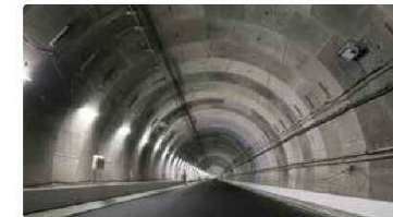
③ 横浜北西トンネル
