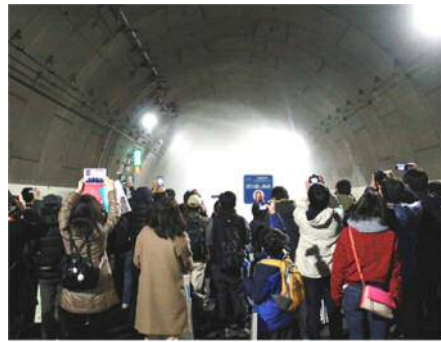
水噴霧デモンストレーション
