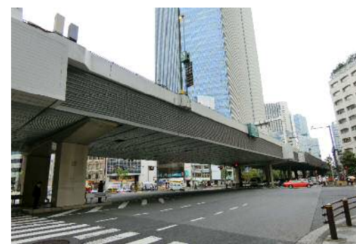
恒久足場*の設置
