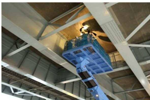
高所作業車による構造物接近点検
