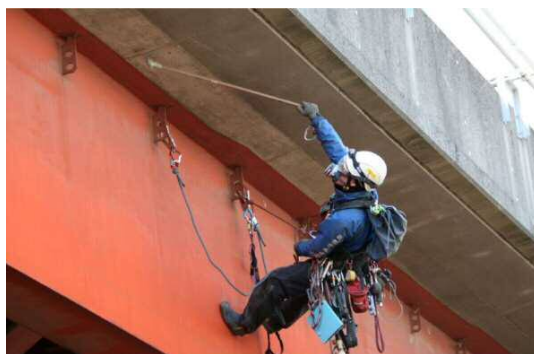
特殊高所技術による構造物接近点検
