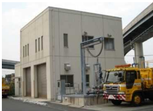
塩水プラント施設
