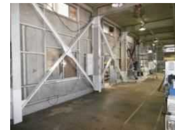
ブレース増設による補強
