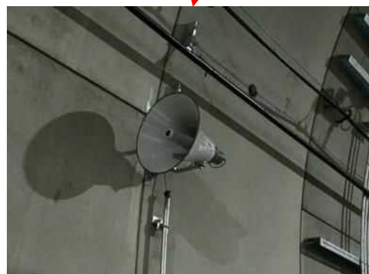
避難情報提供設備の設置事例
