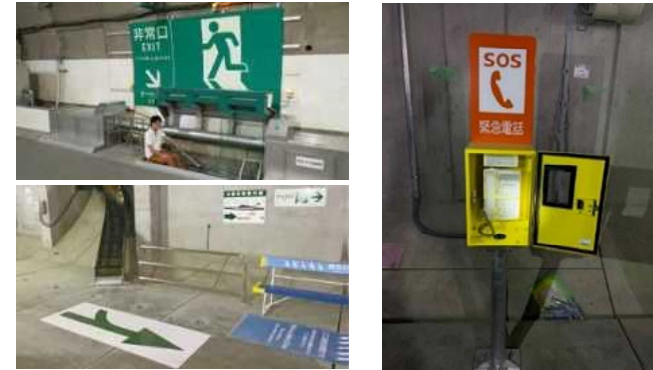
トンネル非常用施設等の誘導案内
