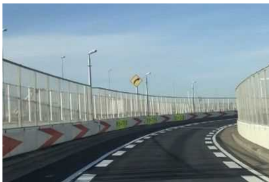
舗装打換え・減速レーンマーク
