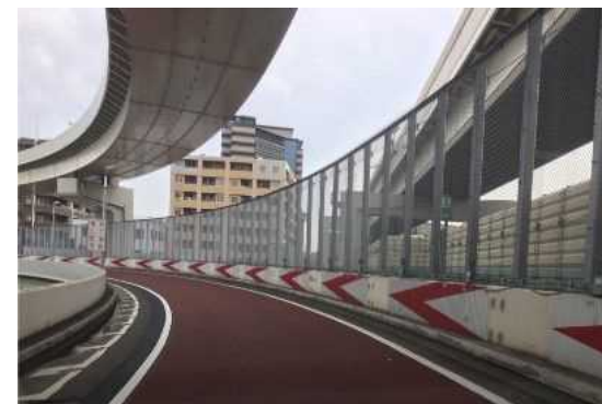
注意喚起カラー舗装、フェンス設置(二輪車安全対策)
