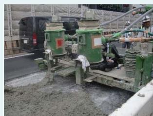
PCM舗装材料打設状況
