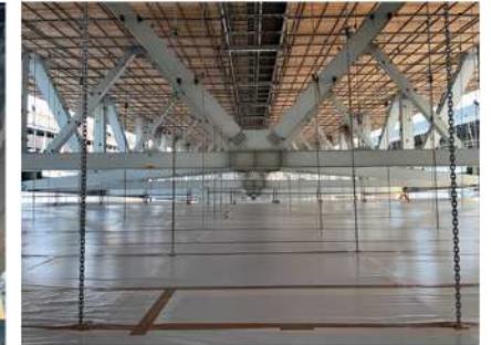
吊り足場(下層)の状況
