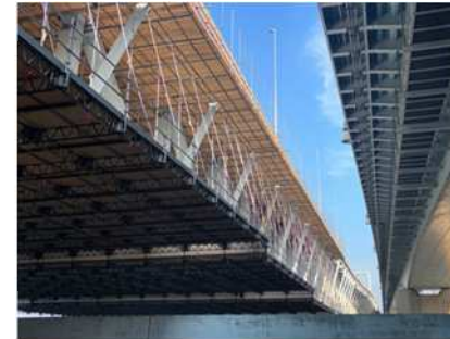
仮設足場設置状況(全景)
