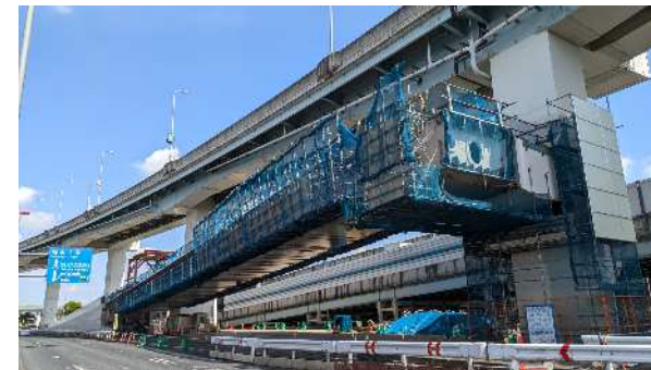
【写真③】与野出口架設工(完了)
