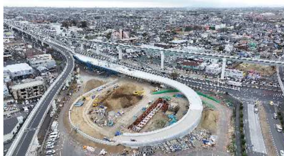
【写真①】与野入口施工状況
