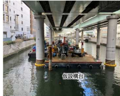
写真② 仮受橋脚工事状況 (日本橋川内 橋脚施工用仮設構台設置)
