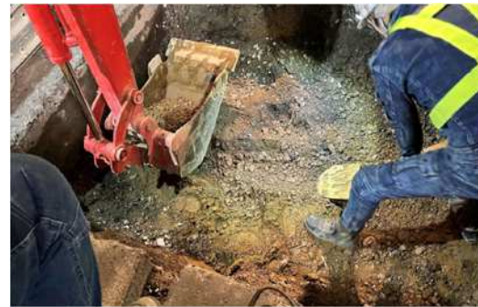
【八重洲地区】地下埋設物調査状況
