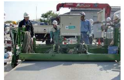
PCM舗装の施工
