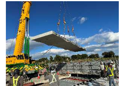
全交換工事の例 出展:日本建設業連合会
