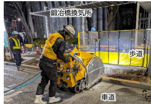
(作業車乗り入れ口整備工)
