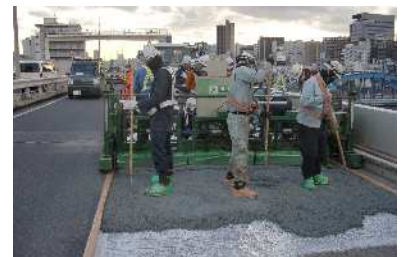
LSF舗装の施工
