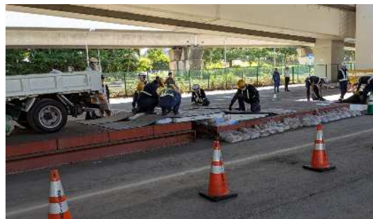
(首都高と横浜市双方が段差啓開)
