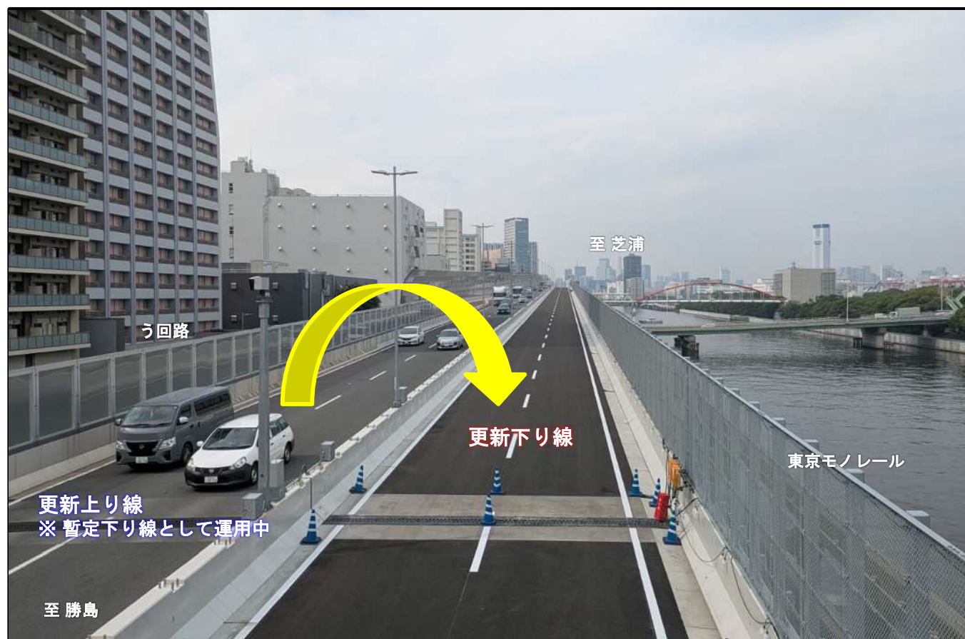
写真 更新下り線工事完了
