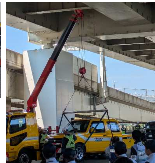
(天秤吊りでの車両排除)
