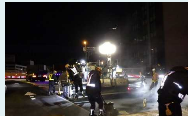
計画的な舗装補修
