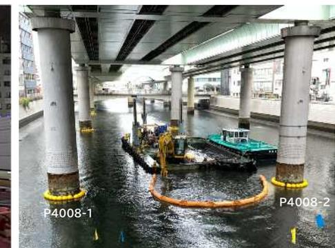
写真③ 仮受4008橋脚 浚渫工
