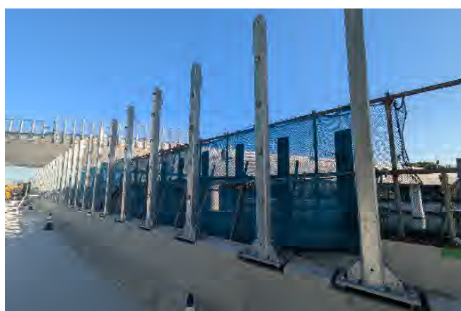
写真② 東品川栈橋部の状況 (落下物防止柵工)
