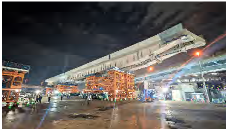
【写真①】一括架設状況(与野入口付近)
