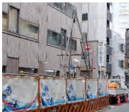
写真① ボーリング調査の状況
