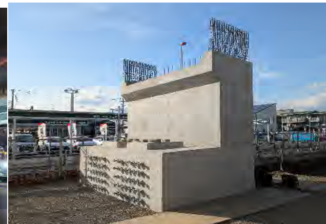
【写真②】橋台工完了状況(与野出口付近)
