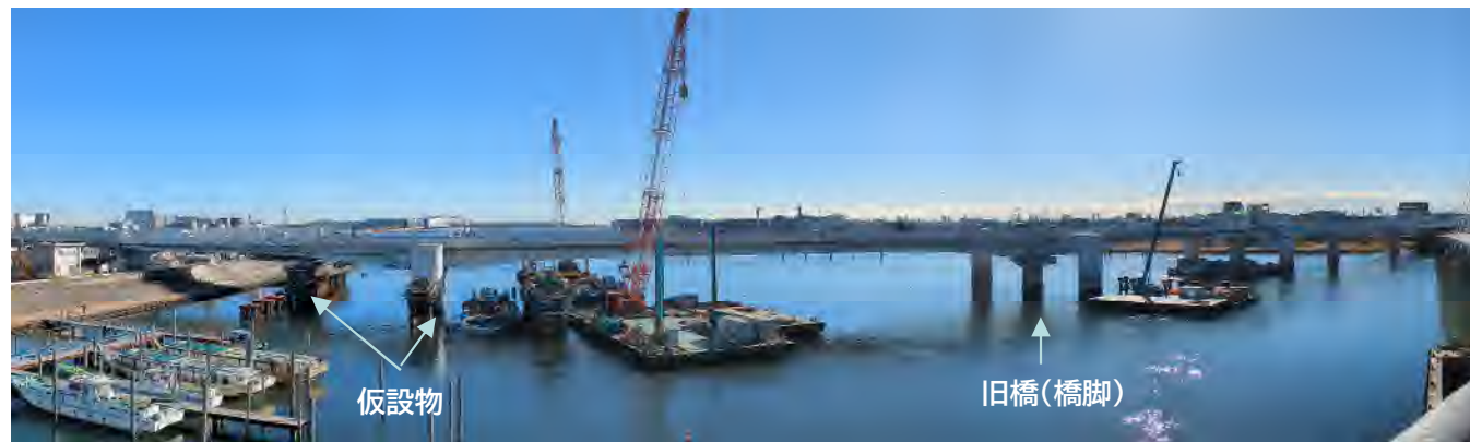
写真② 旧橋(桁)撤去完了状況
