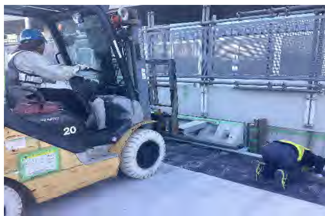
写真① 東品川栈橋部の状況 (地覆工)
