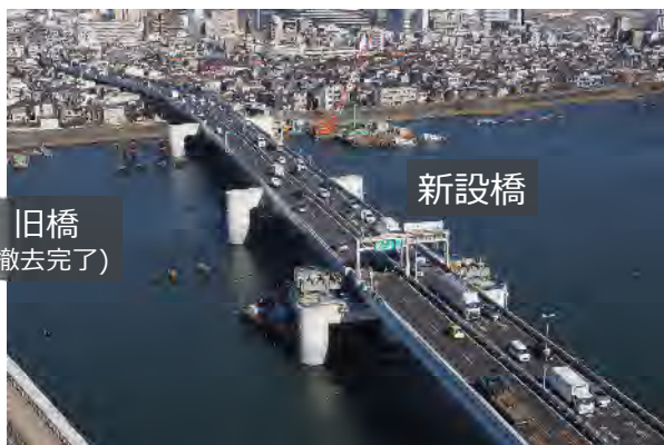
写真① 現場状況(全体)
