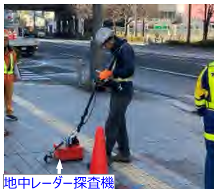
写真② 地下埋設物調査状況
