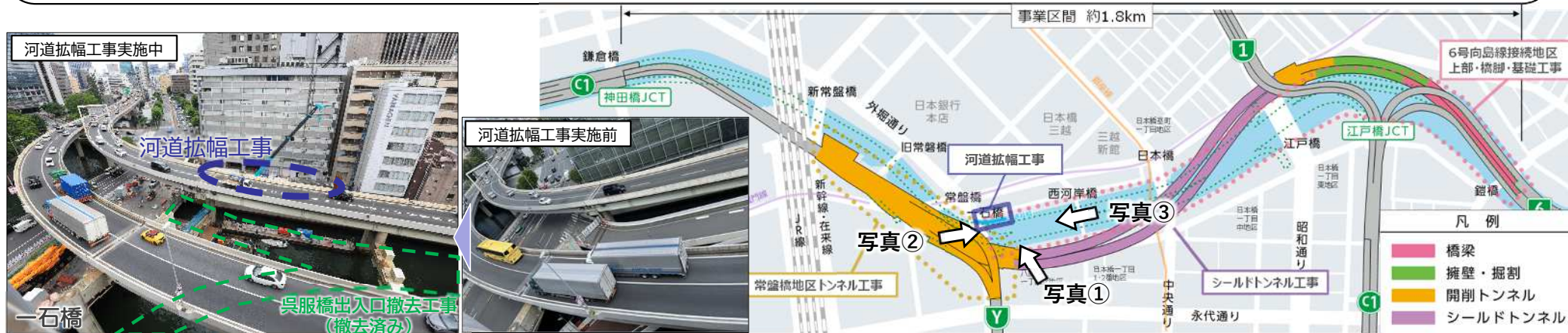
写真① 河道拡幅工事の実施経過
