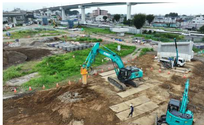
【写真①】地盤改良施工状況(与野入口付近)
