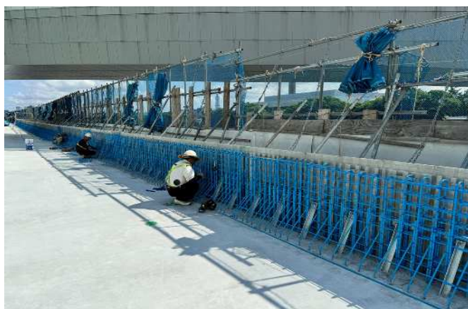
写真② 東品川栈橋部の状況 (高欄工)
