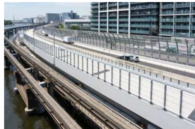
写真③ 鮫洲埋立部の状況 (橋面工完了)
