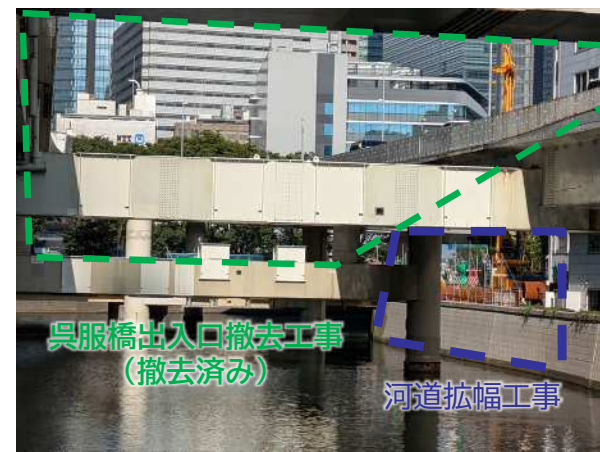
写真③ 呉服橋出入口撤去及び河道拡幅工事の状況
