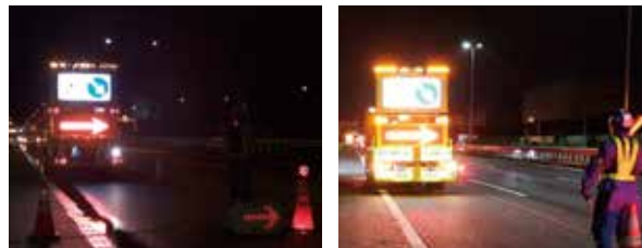
従来 (左) と提灯ドラム発光時 (右) の見え方比較
