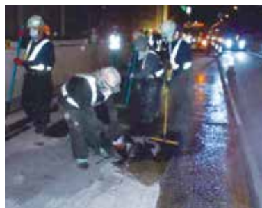
高浸透型防水材料使用状況
