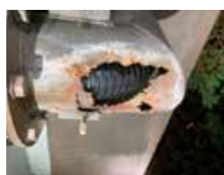
応急補修状況
