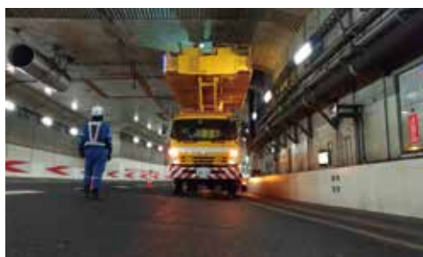
この様な急勾配にも対応可能。またジャッキは自動張り出しのため作業効率化に貢献
