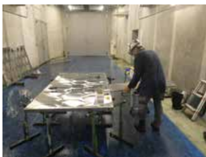
②現場組立式縦横自在建具（組み立て状況）
