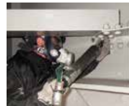
現場施工状況
