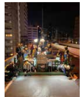
LSF施工状況
