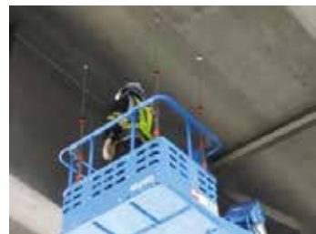
セーフティーポールを使用した点検状況
