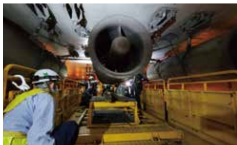
大型作業床が広大な作業空間を確保。また作業床は左右各500mmの拡張も可能
