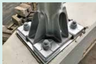
CFRP板接着による鋼桁端部補強工法
