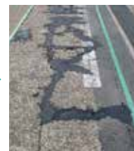
ひび割れ部前処理
