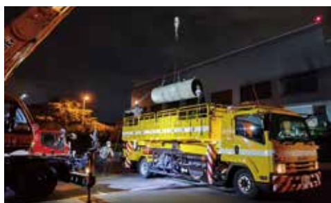
取外したジェットファンはそのまま積載・運搬が可能
