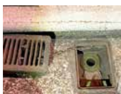
GFRP製定着部の 固定状況
