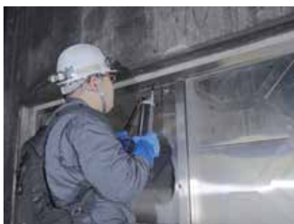
⑤注油装置よりグリスを注油している様子
