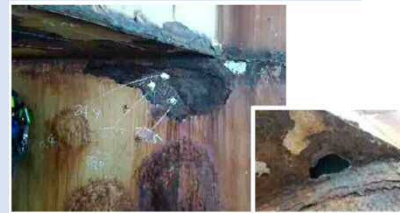
鋼製橋脚の腐食
