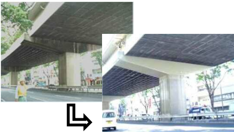
コンクリート橋脚はく落防止対策
