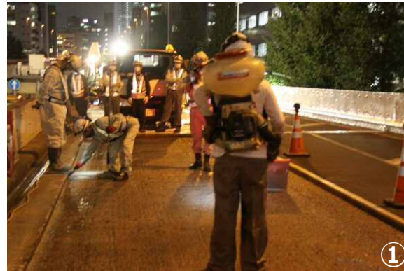
① 浸透型防水工 [ 浸透型防水材料により既設床版の防水に加えて 既設床版のひび割れ補修を実施 ]
