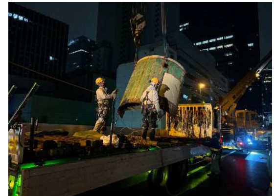
写真③ 呉服橋出入口 橋脚撤去状況
