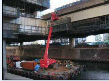
近接点検（河川上）
