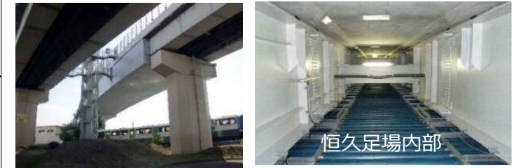
仮設足場の設置困難箇所へ設置
