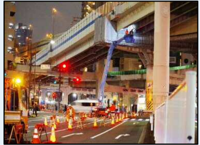
接近点検（街路上）
