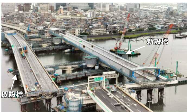
既設橋のスライド撤去状況
