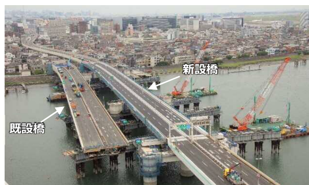
新設橋のスライド架設状況
