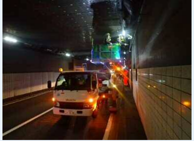
近接点検（トンネル内）
