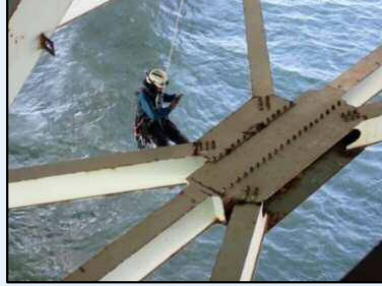
近接点検（ロープによるアクセス）
