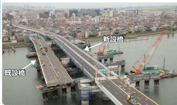
新設橋のスライド架設状況
