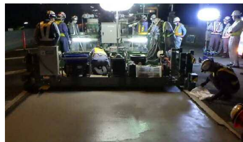
施工状況（1号上野線）
