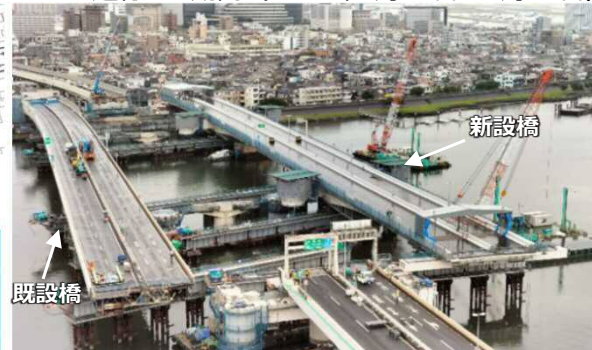
既設橋のスライド撤去状況
