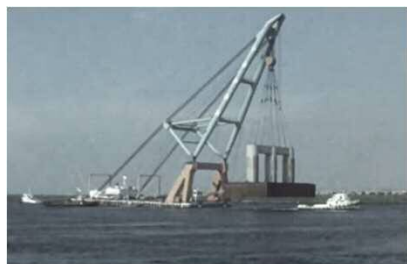
巨大な鋼鉄製の橋脚
