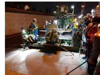
施工状況（7号小松川線）
