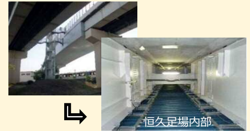
仮設足場の設置困難箇所へ設置
