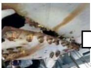
損傷部位（ガセットプレート）等の補修・取替
