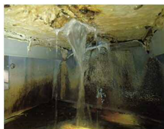
構造目地の漏水
