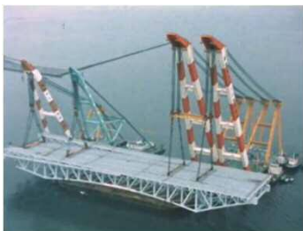
一径間分を一挙に架設
