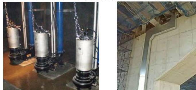
2相ステンレス鋼材製ポンプ 高耐食性配線カバー
