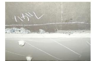
補強鋼板の剥離(浮き)
