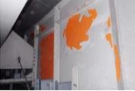
塗膜劣化に起因した鋼材腐食 (2022.1)
