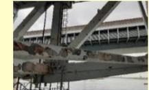
塗膜劣化に起因した部材破断 (2021.3)
