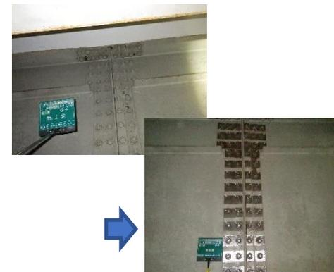
破断の恐れのある高力ボルトの取替
