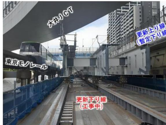
写真① 現在の状況（更新下り線 橋桁架設工）
