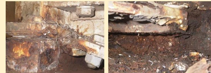
支承の腐食による固着（桁の移動が拘束）
