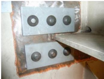
鋼桁を破断するような損傷発生の可能性のある部位を補強
