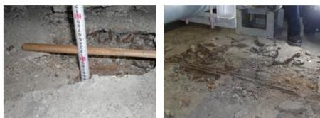
中床版上面のはく離・断面欠損・鉄筋腐食
