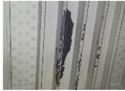
塗膜劣化に起因した鋼材腐食 (2020.12)
