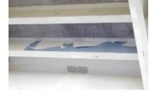
塗膜劣化に起因した部材破断 (2021.11)
