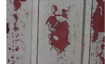
塗膜劣化に起因した鋼材腐食 (2019.1)
