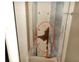
補強鋼板の腐食
