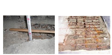
中床版上面のはく離・断面欠損・鉄筋腐食
