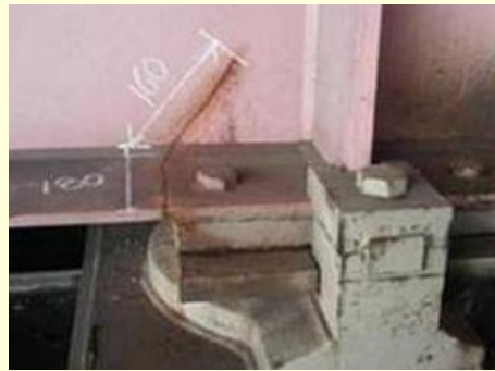
主桁本体に発生した疲労き裂 ⇒さらに進展すると落橋の恐れ
