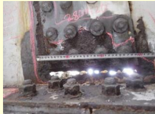
塗膜劣化後、腐食が進行した断面欠損
