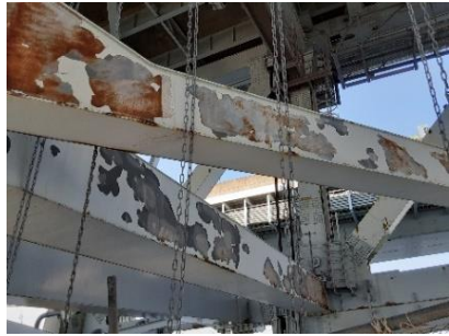
トラス部材の腐食
