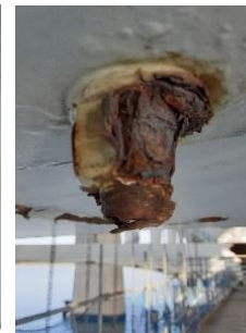
高力ボルトF11Tの腐食・破断
