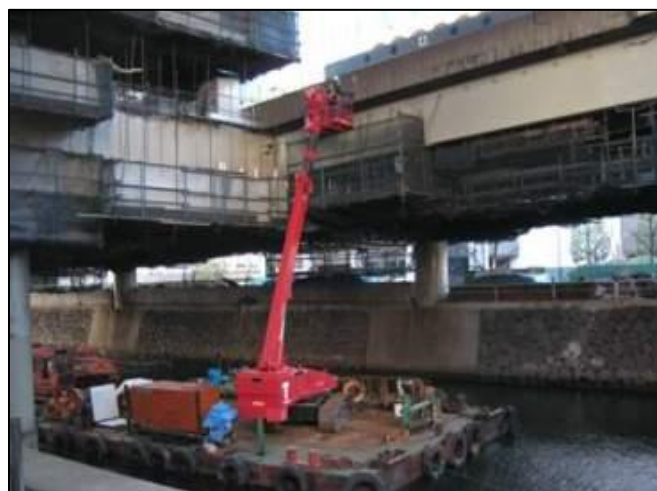
接近点検（河川上）
