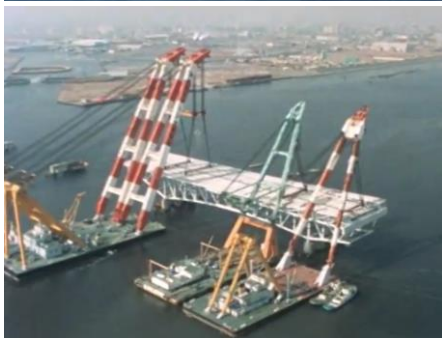
建設時の架設状況
