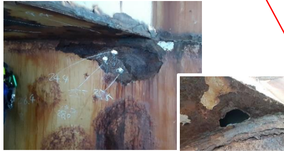
鋼製橋脚の腐食
