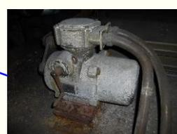
排煙設備の腐食
