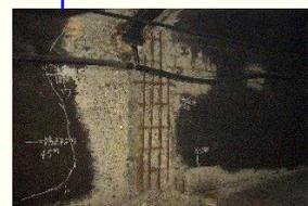
側壁部の剥落
