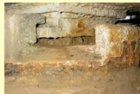
桁連続化・・・ゲルバー部を連結（支承撤去）して、狭隘部を解消
