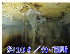
継手部の漏水
