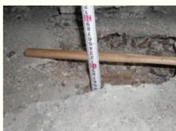
中床版上面の剥離・断面欠損
