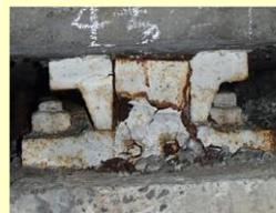
支承の固着（主桁損傷リスク）
