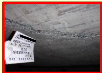
天井面のひび割れ
