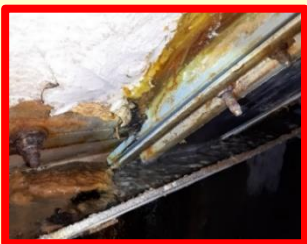
排水樋からの漏水 (流量超過、堆積)
