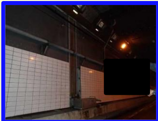
断面修復+タイル復旧
