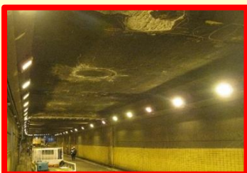
中床版下面の浮き・剥離
