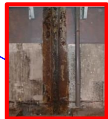
継手部からの漏水 【内空制約により対策困難】
