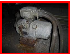
排煙用モータの腐食
