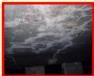
天井面のひび割れ・遊離石灰
