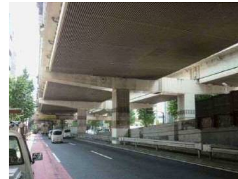
現地の状況（三軒茶屋付近）
