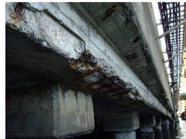
更新前の状況（東品川栈橋部）
