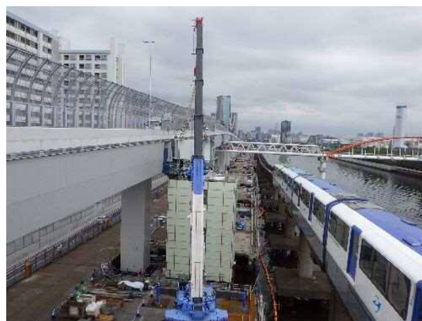
写真① 現在の状況（更新下り線橋脚工）
