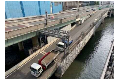
写真② 足場設置状況
