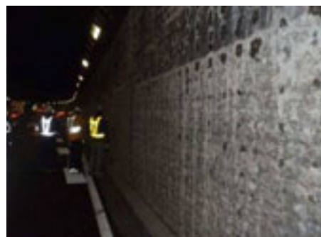
側壁コンクリート部の躯体調査 (霞が関トンネル)
