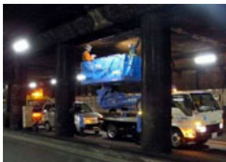
接近点検 (霞が関トンネル)
