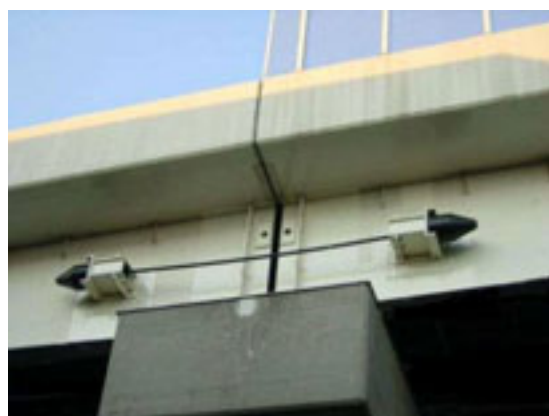
図 4.4.9 支承・連結装置耐震補強(連結装置の設置)
