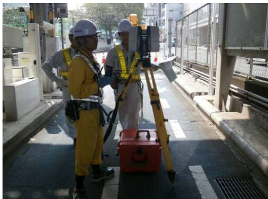
<損傷箇所特定や損傷状況確認の効率化>
