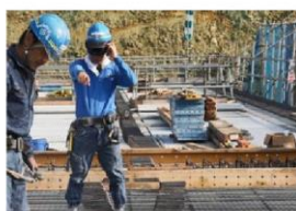
写真-1 鉄筋組立（配置）使用例
