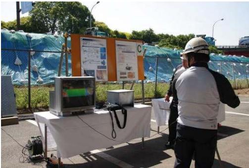
コンクリートの空洞調査（赤外線カメラ）
