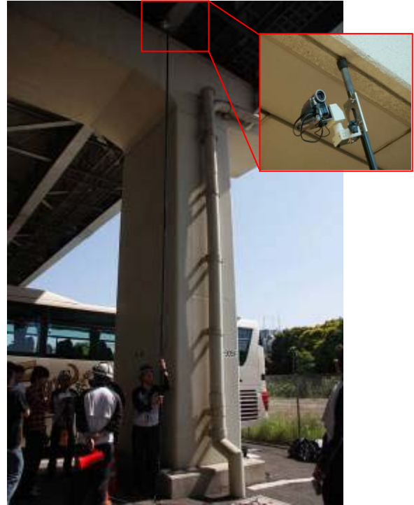
ポールカメラを用いた狭隘部の点検
