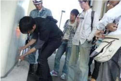
コンクリート強度測定
