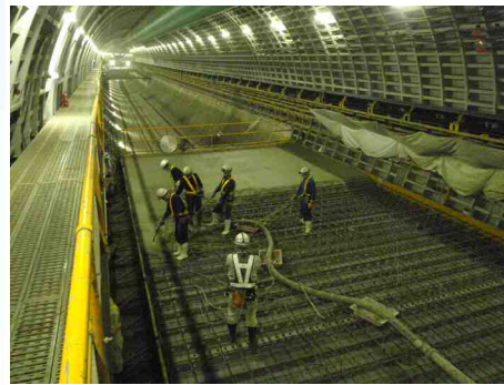
シールドトンネル床版工事
