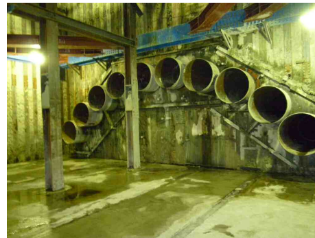
五反田出入口工事
