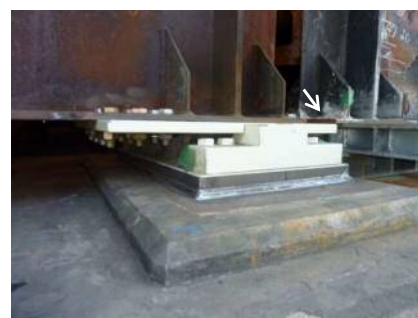
写真:3 支承の原形復旧状況
