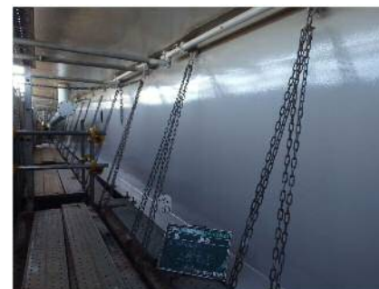
写真:4 塗装完了状況
