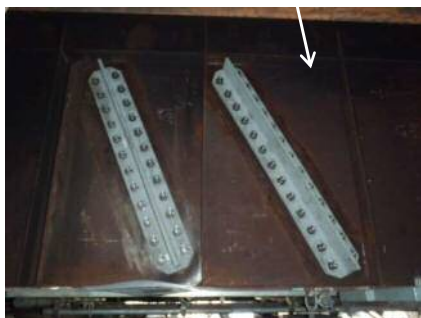
写真:1 主桁腹板の鋼部材による補強状況
