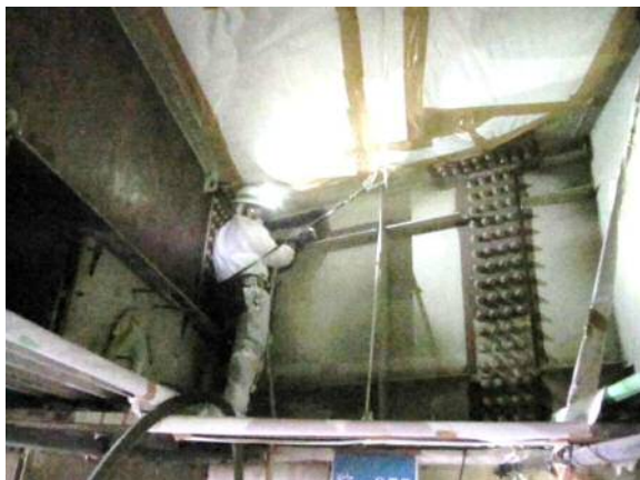
【素地調整2種の1次仕上げ作業状況】
