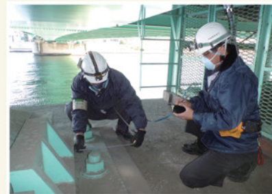
橋脚上の現地調査
