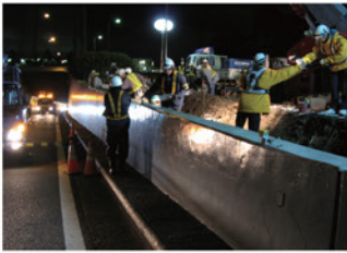
工事前後の点検（首都高下での掘削工事）
