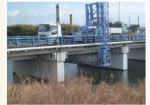
大型橋梁点検車による点検(国道6号)
