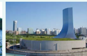
新横浜換気所
