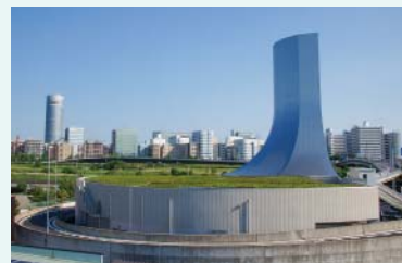
新横浜換気所
