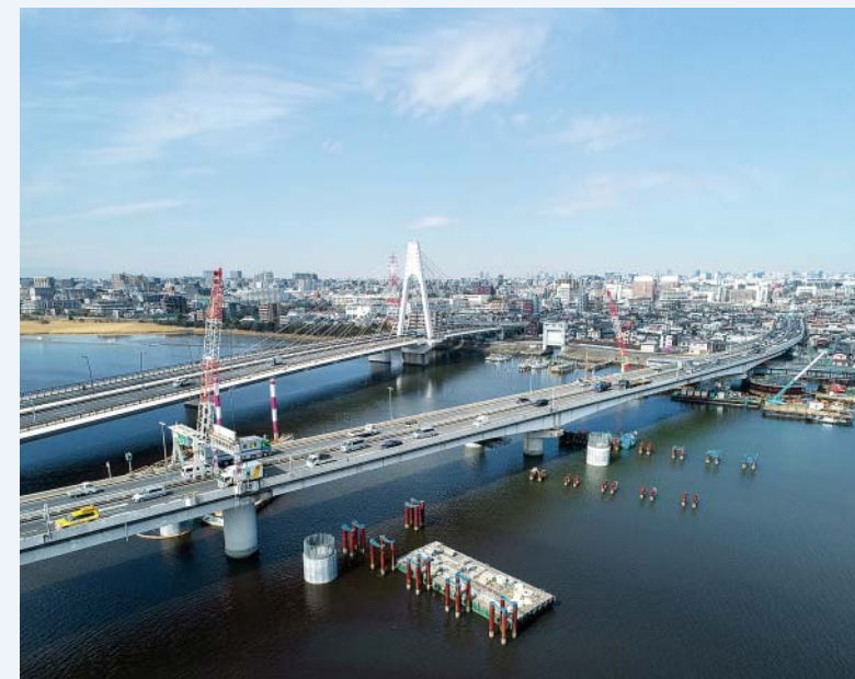
高速大師橋施工状況(2021年2月)
