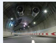
トンネル照明のLED化
