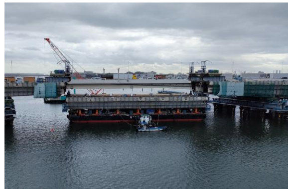
写真② 一括吊り下げ撤去状況
