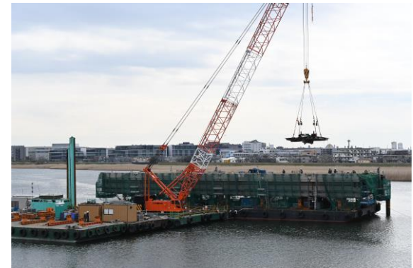
写真③ 台船上での解体状況
