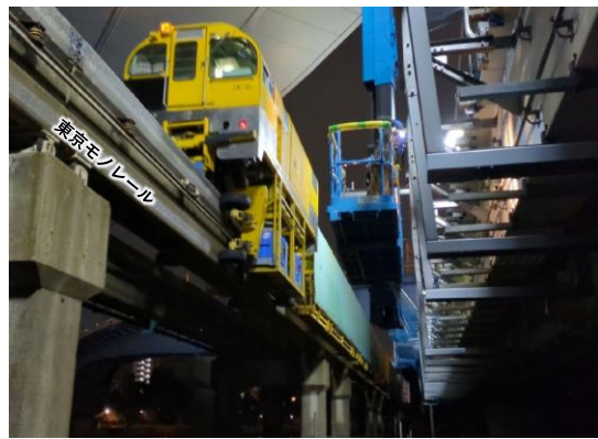
写真② 東品川栈橋部の状況 (恒久足場設置工)
