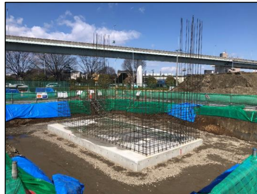
橋台施工状況(与野JCT付近)
