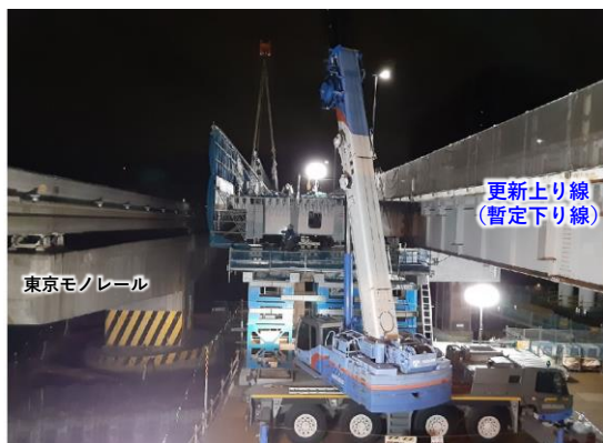
写真① 東品川栈橋部の状況 (主桁架設工)
