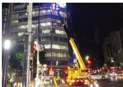
メンテナンス事業（一般道照明設置工事）
