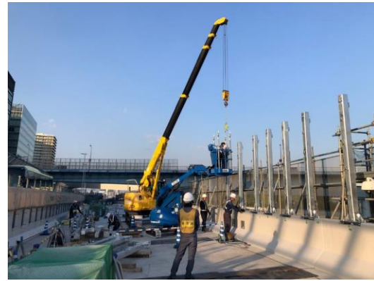
写真③ 鮫洲埋立部の状況 (落下防止柵設置工)
