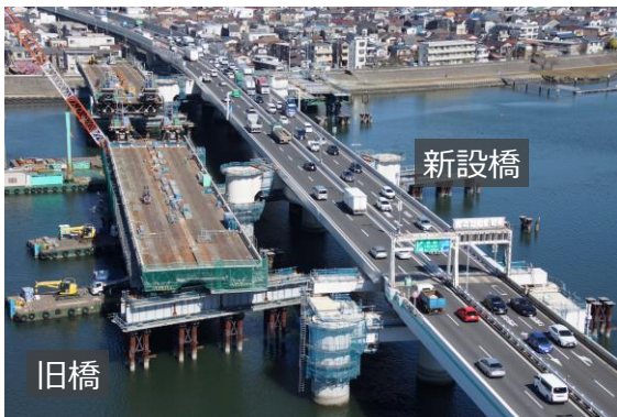
写真① 現場状況(全体)
