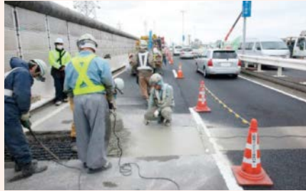
土木構造物(伸縮継手)の補修
