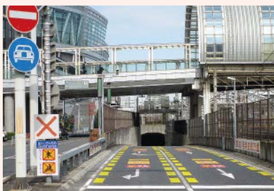
立入防止カラー舗装
