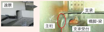
鋼桁の接続部(切欠き部)
