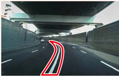
区画線白実線化・車両接触事故対策 (板橋～熊野町JCT間)
