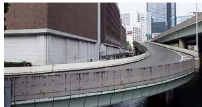
江戸橋入口の桁撤去前
