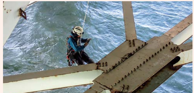
海上部でのロープを使ってアクセスする点検
