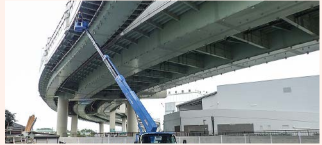
橋梁の接近点検
