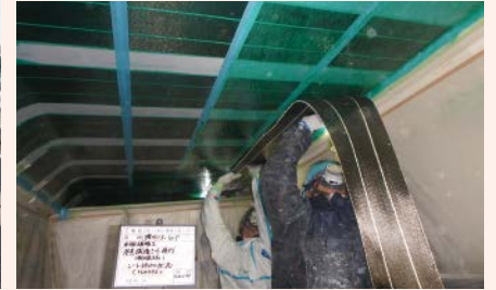
土木構造物(コンクリート床版)の補強
