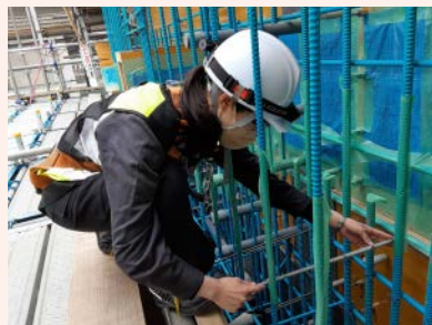
側壁の配筋検査状況
