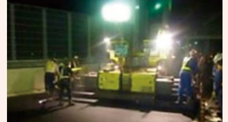
舗装工事実施状況
