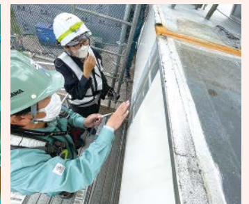
縦桁の溶接前検査状況
