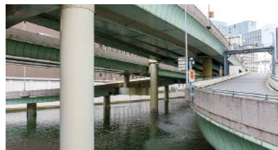
江戸橋出口の桁撤去前
