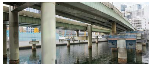
江戸橋出口の桁撤去後
