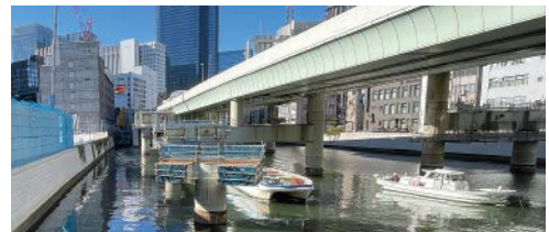
江戸橋入口の桁撤去後
