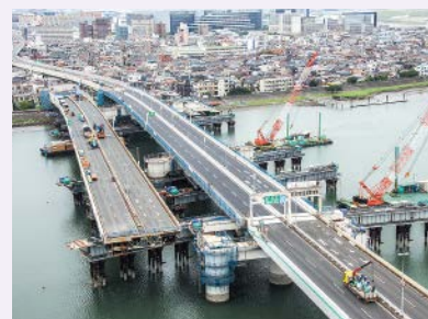
高速大師工事
