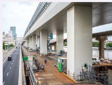
高速1号羽田線更新工事
