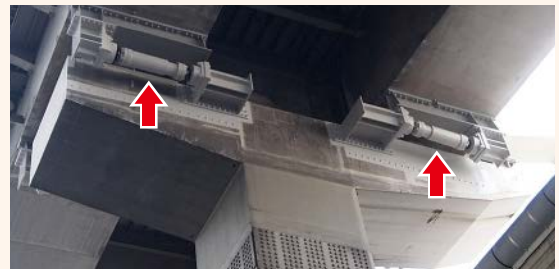
ダイス・ロッド式摩擦ダンパー
