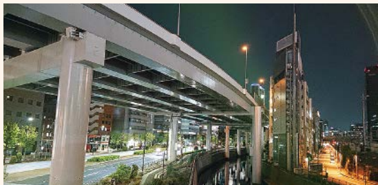
水性塗料を用いた塗替え
