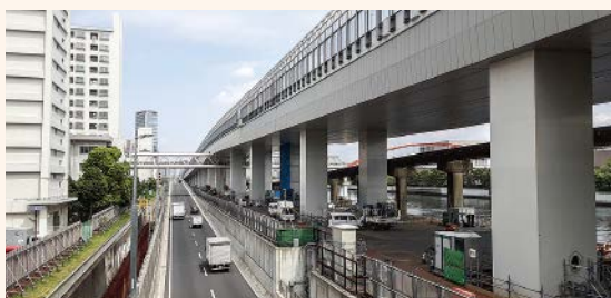
東品川栈橋部の現場状況
