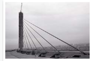
建設中のかつしかハーブ橋
