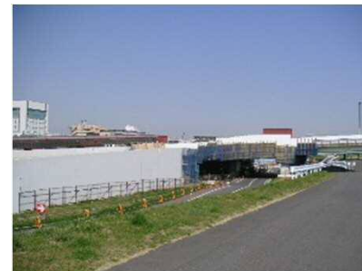
センターランプ施工状況（写真3）
