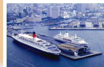
▲ 横浜港大栈橋
