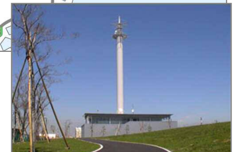
▲ 東扇島基幹の広域防災拠点施設
