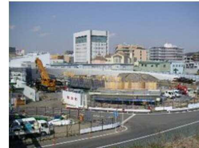
ループランプ施工状況（写真4）
