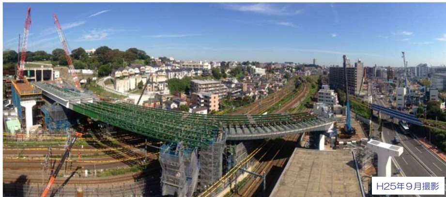
⑤ 子安台換気所付近（鉄道交差部：送り出し架設） 施工状況
