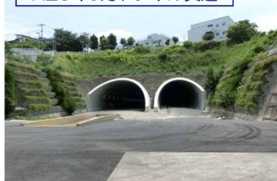
坑口付近施工状況（写真1）
