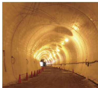
国道1号方向行きトンネル内施工状況（写真2）
