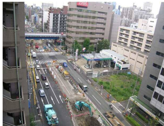
②五反田出入口の施工状況
