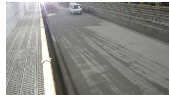
③本線シールド床版の施工状況
