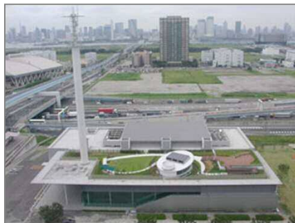
▲ 有明の丘基幹的広域防災拠点施設
