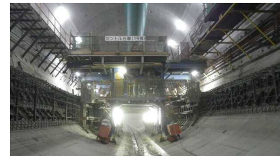
③本線シールドの施工状況
