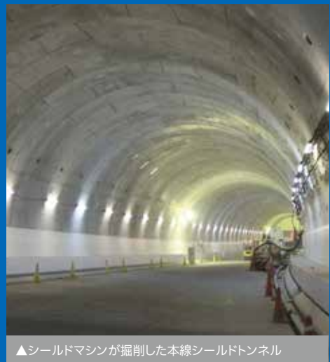
▲シールドマシンが掘削した本線シールドトンネル
