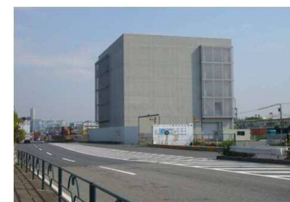
写真④ 大井北換気所(施設工)
