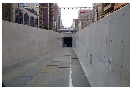
写真② 五反田入口（躯体工）
