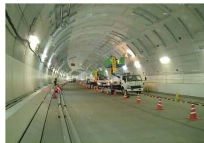
写真③ 本線シールド内(施設工)
