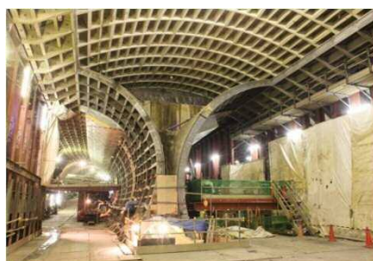
写真① 大橋連結路（接続工）
