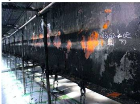
【①下り線 足場内】 撮影日:3/22
