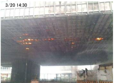
【②下り線 足場下】 撮影日:3/20
