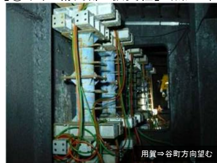
【④下り 桁内部 仮支柱】 撮影日:3/23
