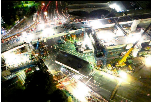
平成25年9月7日 桁架設状況
