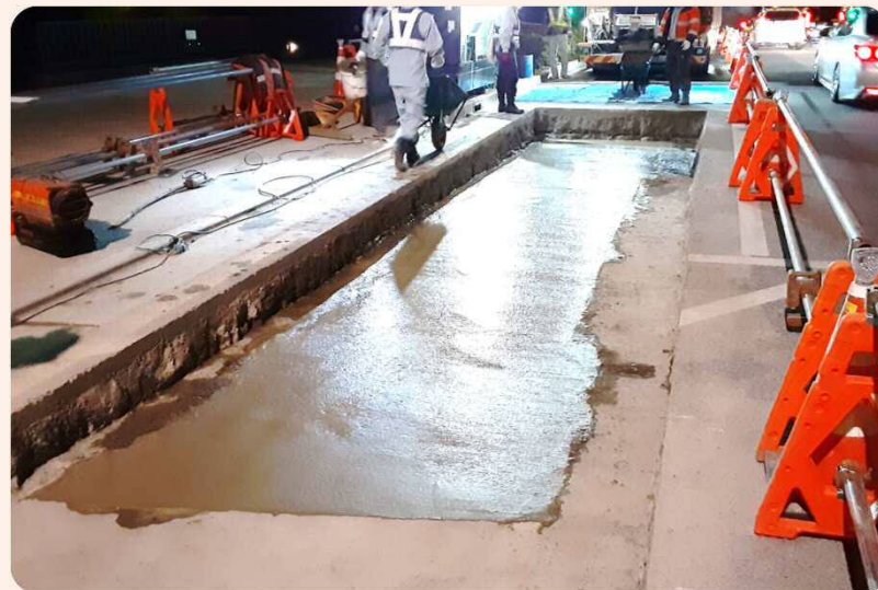
コンクリート復旧状況（打設完了）
