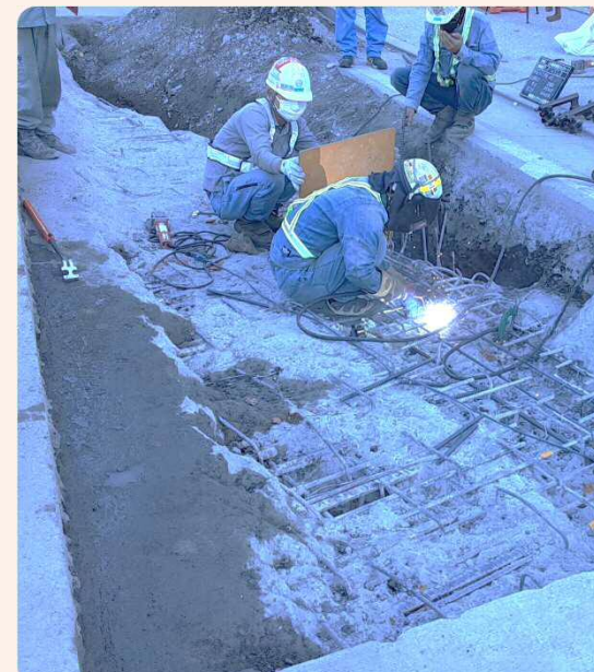
鉄筋接合作業（11/19）
