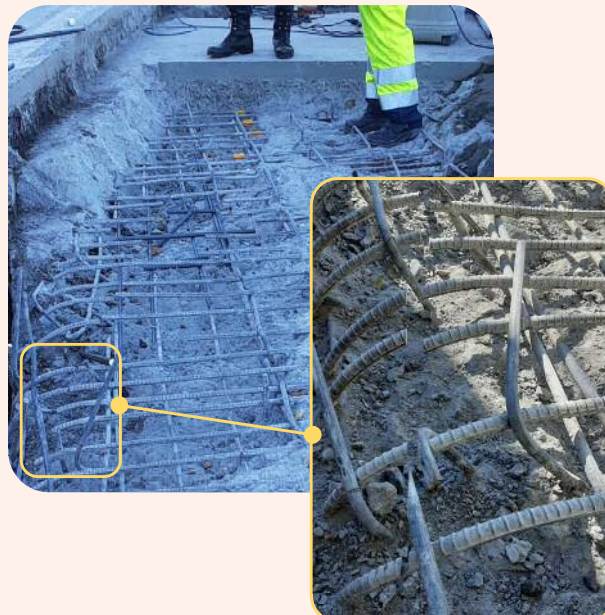
コンクリート研り作業（鉄筋損傷状況）（11/18）
