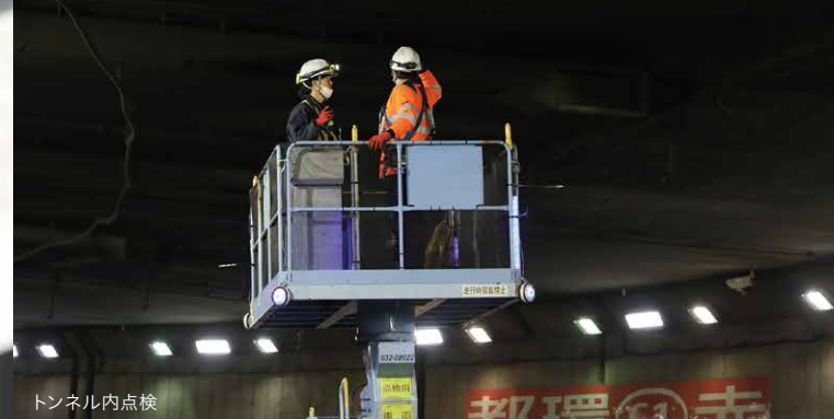
トンネル内点検
