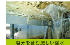
塩分を含む激しい漏水
