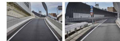
首都高合流部の例 特徴: 右側合流、上り勾配、遮音壁設置、合流車線が短い等
