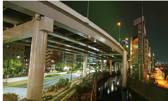
高速5号池袋線飯田橋駅付近
