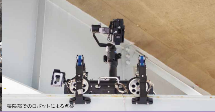
狭隘部でのロボットによる点検
