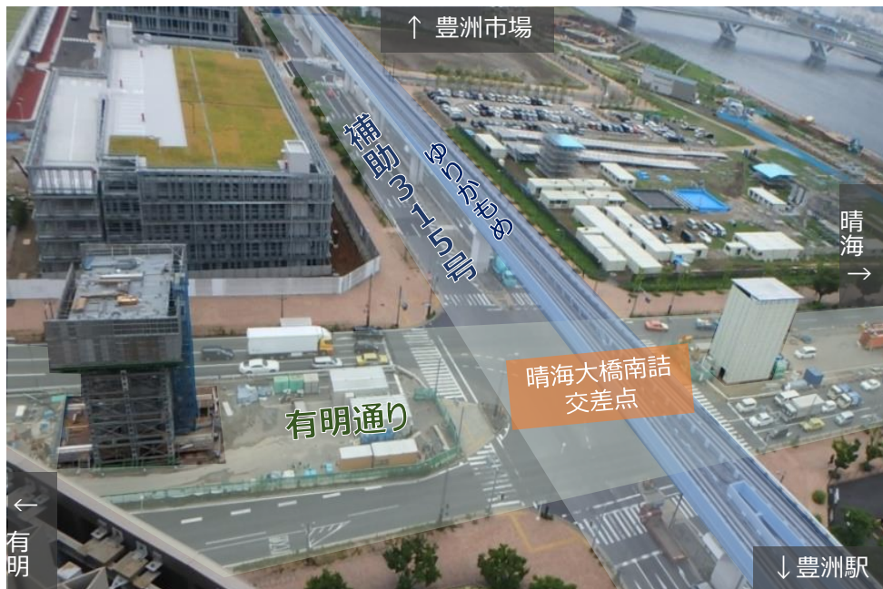
▲当該箇所 桁架設前の様子
