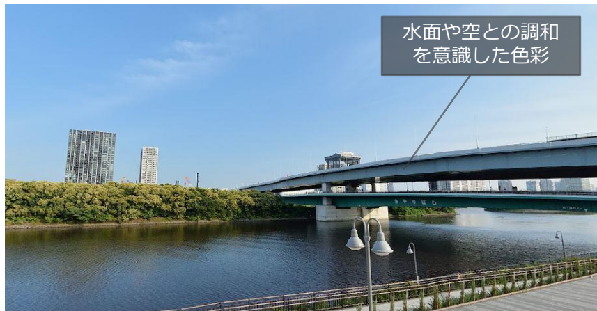
▲ 豊洲運河渡河部 付近
